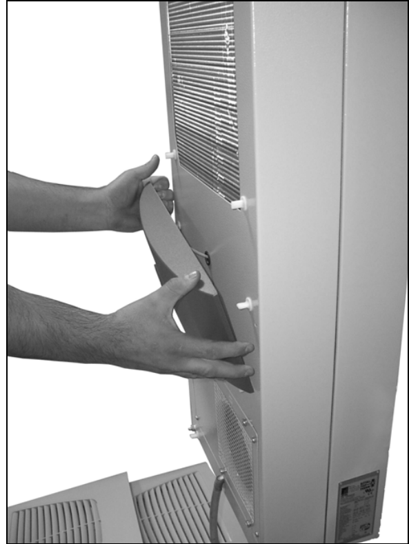
Fig. 37: Remove the infill panel
