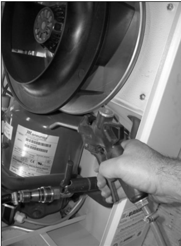
Abb. 52: Wärmetauschregister und Kompressorraum mit Druckluft ausblasen (2)
