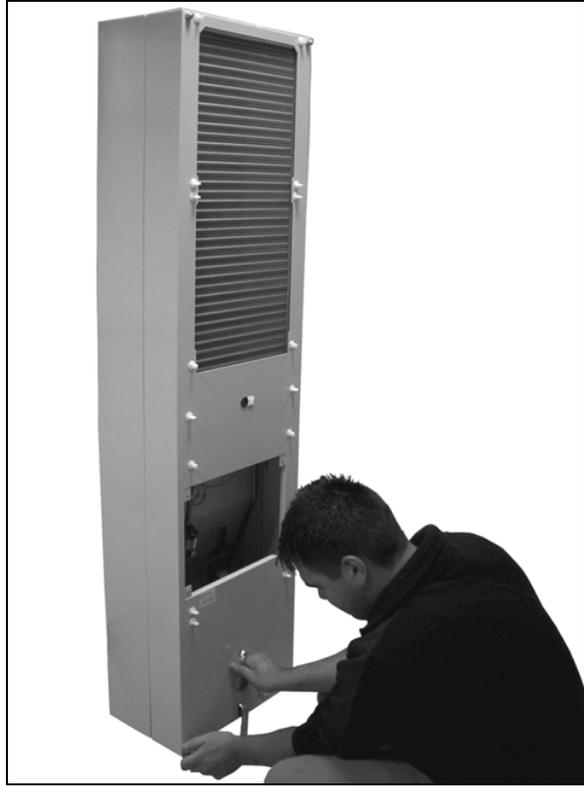
Abb. 70: Vier Muttern der Haube lösen
