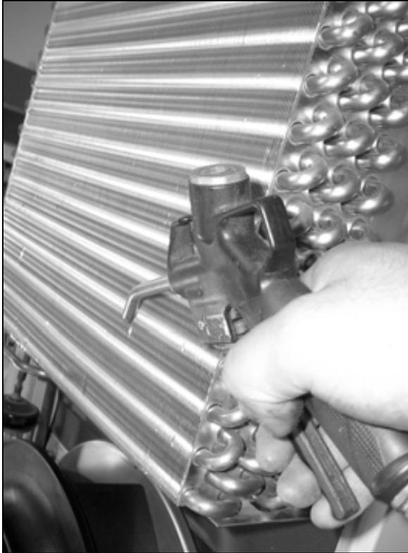
Abb. 51: Wärmetauschregister und Kompressorraum mit Druckluft ausblasen (1)
