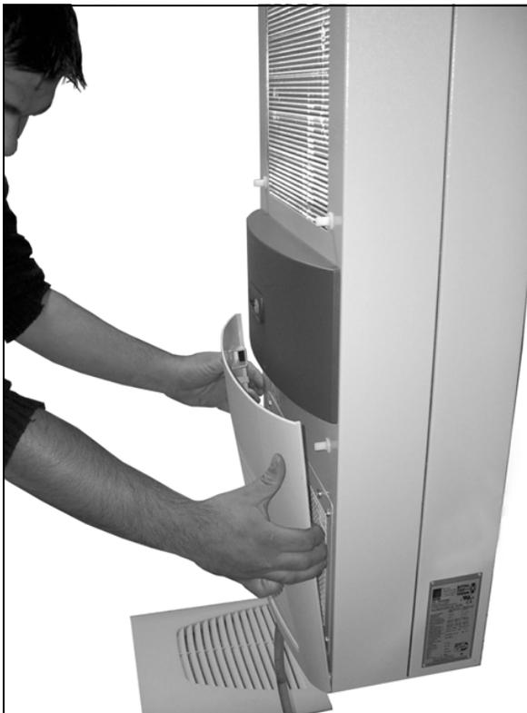
Abb. 36: Unteres Lamellengitter entfernen
