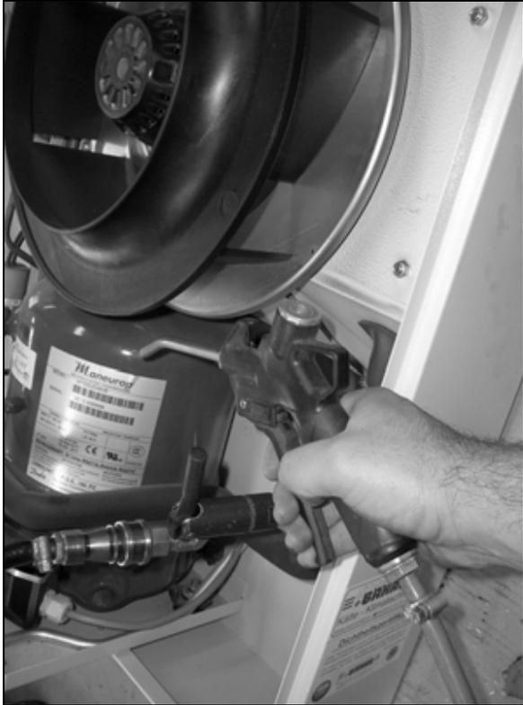
Abb. 76: Wärmetauschregister und Kompressorraum mit Druckluft ausblasen (3)
