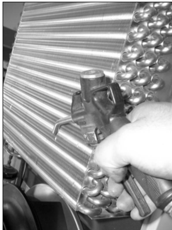
Abb. 75: Wärmetauschregister und Kompressorraum mit Druckluft ausblasen (2)
