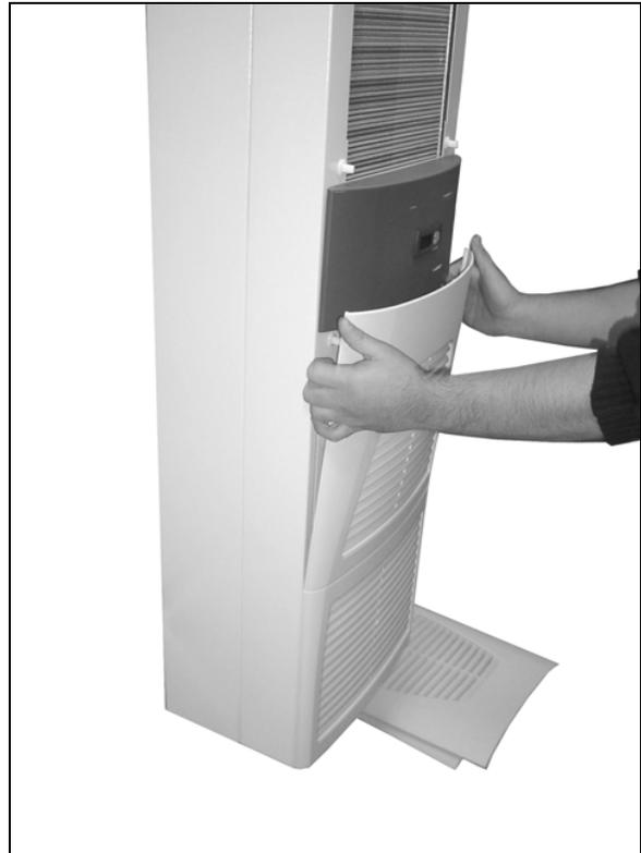
Abb. 57: Unteres Lamellengitter entfernen (1)
