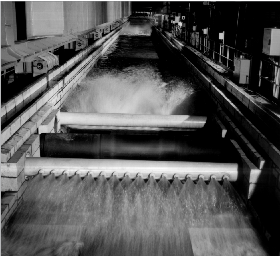
Vorbehandlungsanlage in einer Heizlinie
